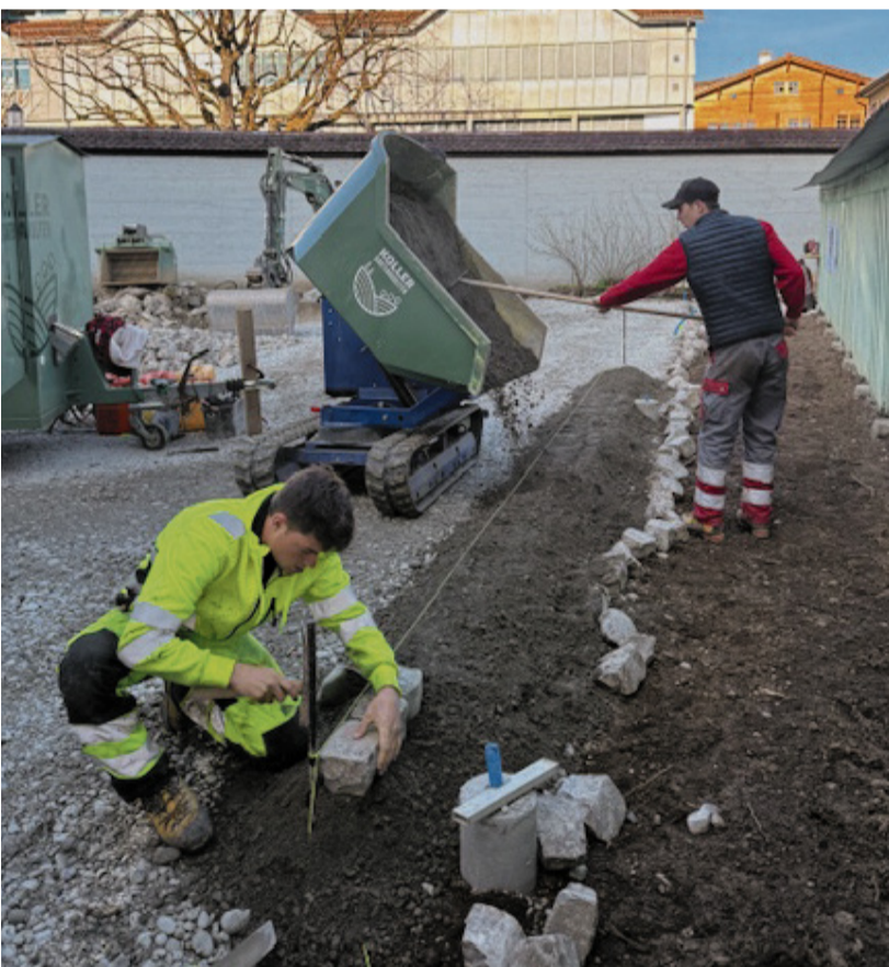
Silvan Brülisauer und Jaro Koller setzen die Randabschlüssen der Gehwege. (Bild: zVg)
